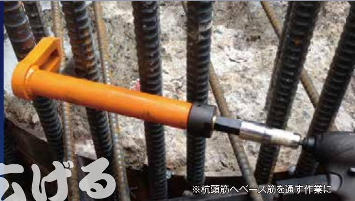
※杭頭筋へベース筋を通す作業に
