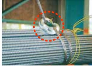
「Cカン」を使って、絞り吊りで鉄筋の、積み降り移動中。
