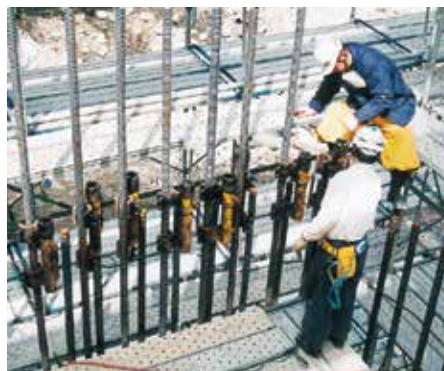
・鉄筋がバイスに順次着地するため作業がしやすい。
