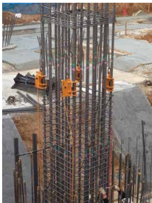
・鉄筋がバイスに順次着地するため作業がしやすい。
